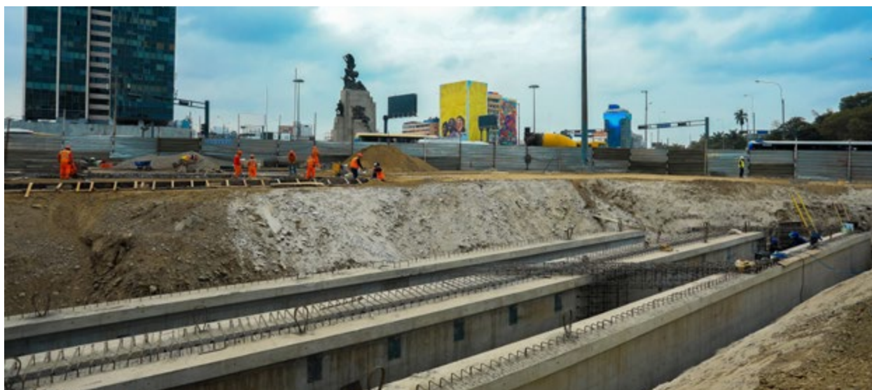
Foto: MTC - Estación Central de la Línea 2.
